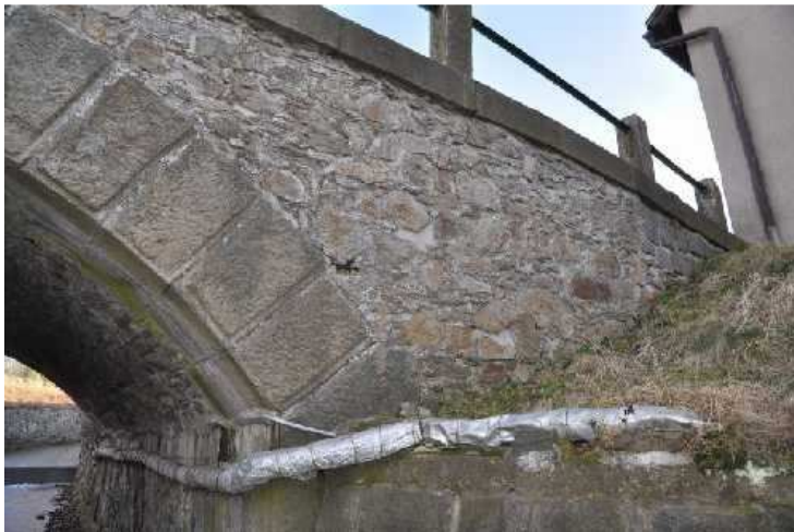
Čelní zeď nad opěrou 2 vpravo - je zde patrné vyboulení a vyklonění zdi ven z mostu.
