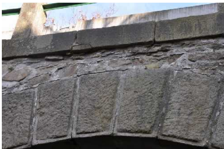
Pískovcové klenáky vpravo s rozvolněnou čelní zídkou a s rozvolněnými kamennými deskami římsy.
