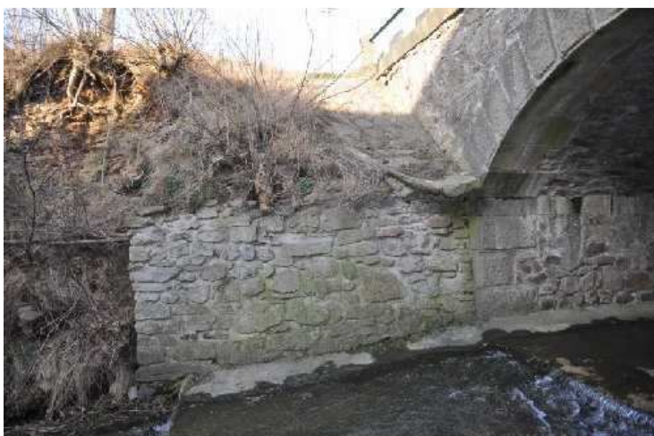
Napojení nábrežní zdi na opěru 1 vpravo na povodní straně.
