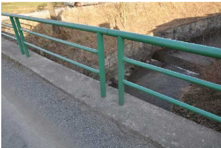
Nadbetonovaná římsa vlevo.
