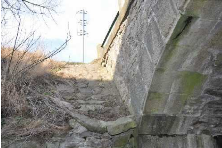
Čelní zeď nad opěrou 1 vpravo - je zde patrné vyboulení a vyklonění zdi ven z mostu.
