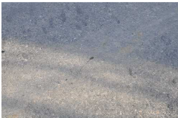
Vozovka z penetračního makadamu.
