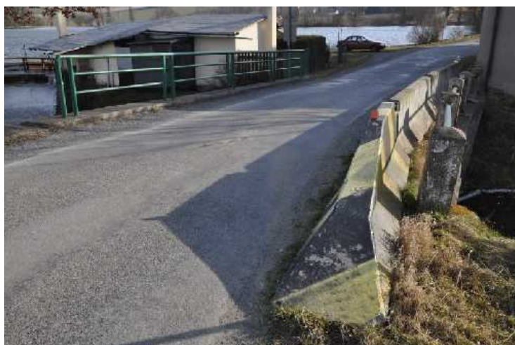
Vyřešení nevyhovujícího zábradlí a vykloněné čelní zdi.
