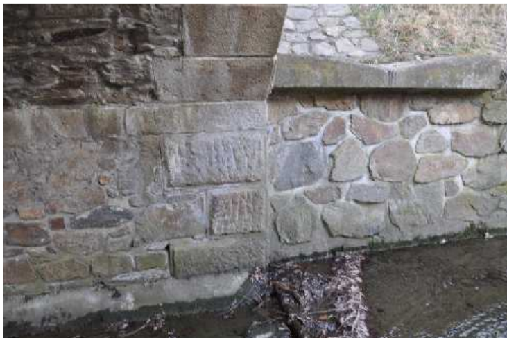
Opěra 1 vlevo - potečená a s rozvolněným nárožím..
