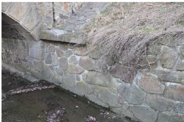
Navázání nábrežní zdi na opěru 1 vlevo na návodní straně.
